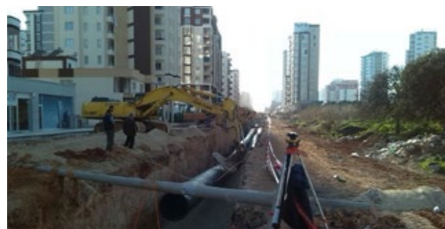
Rohrverlegung HDPE 1200 mm doppelter Graben in Felsregion Pipe laying of HDPE 1200 mm double trench in rock area
