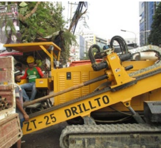
Grabenlose Rohrverlegung (HDD) Trenchless pipe laying HDD
