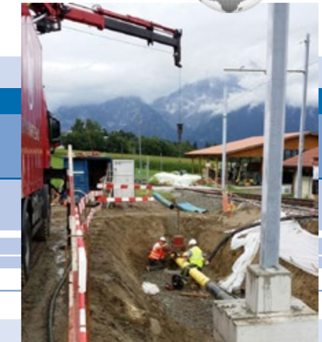
Beendigung der Arbeiten – Verschließen der Stopple-Stutzen mittels Setzgerät und Spezialstopfen (Plug) Finishing the work – closing the Stopple nozzles using a setting tool and special plugs (Plug)
