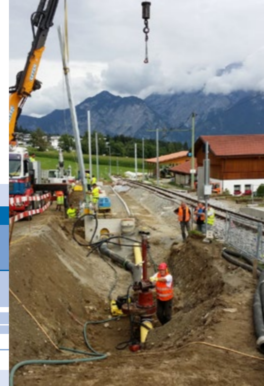
Anbohrung der Stopple-Stutzen mittels Schleuse und Druckluftbohrmaschine Opening up the Stopple nozzles with a sluice and a pneumatic drill
