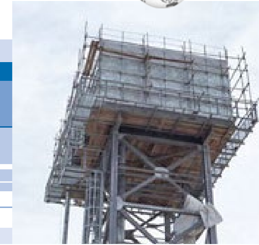
Trennwand und Seite fertig gestellt Division and side completed
