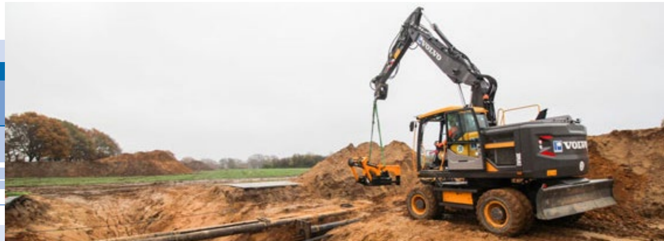
EW 160 E im Einsatz auf einer Baustelle in Stade-Ohrensen EW 160 E used on a construction site in Stade-Ohrensen
