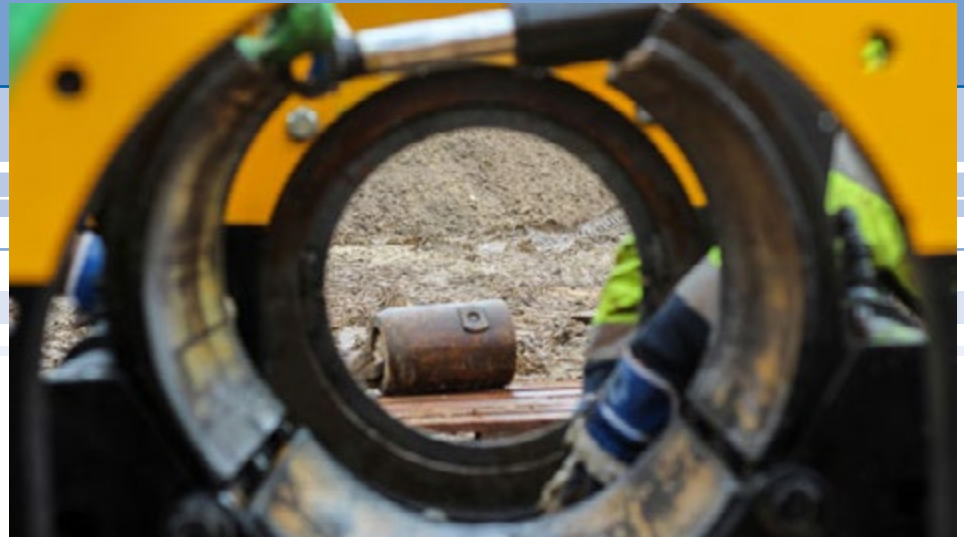
Rohreinzug für das DynTec-Verfahren in Stade-Ohrensen Pipe intake for the DynTec process in Stade-Ohrensen
