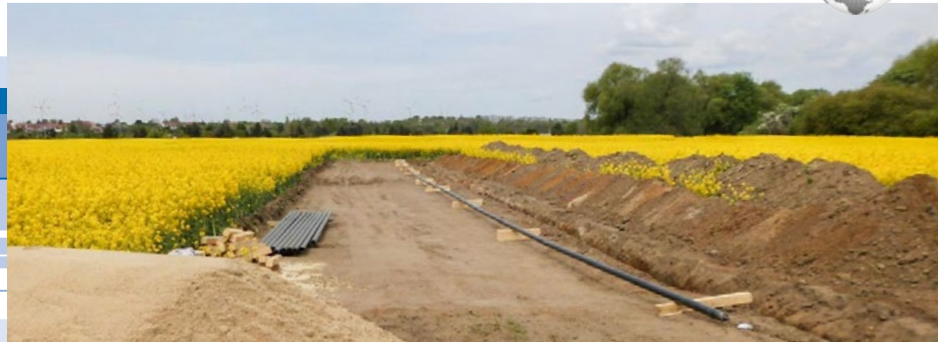
Arbeitsstreifen/Rohrbau Maßnahme 3 Work Strips/Pipeline Construction Stage 3
