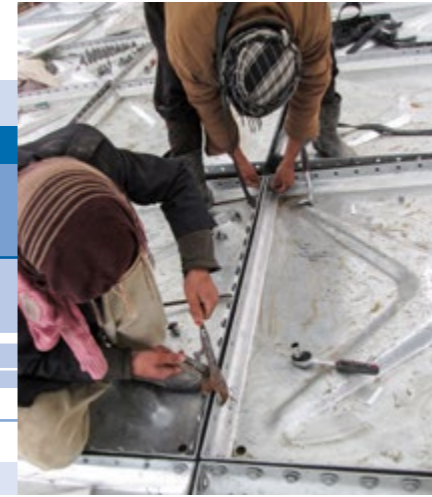
Montage der kleinen Wand Assembly of the small wall
