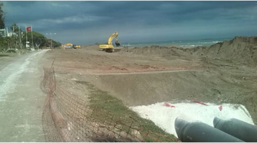
Verfüllung des Grabens HDPE 1200 mm in der Küstenregion Trench backfilling HDPE 1200mm in the coast area
