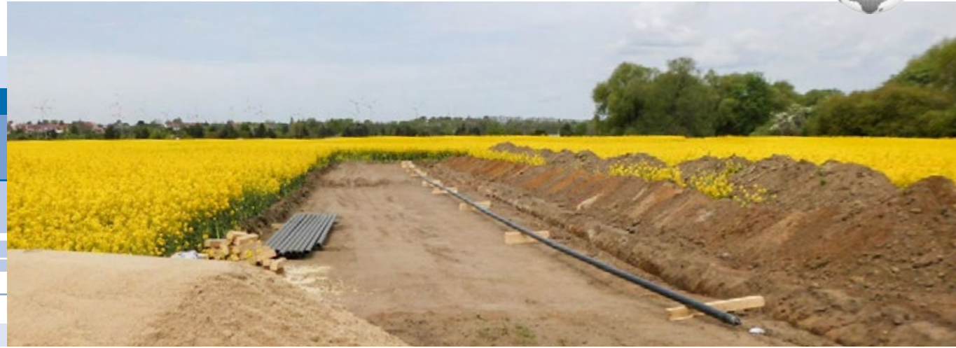
Arbeitsstreifen/Rohrbau Maßnahme 3 Work Strips/Pipeline Construction Stage 3
