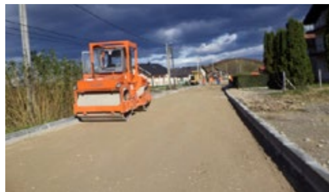
Vorbereiten des Untergrundes vor dem Asphaltieren Preparing the subsoil before asphaltting
