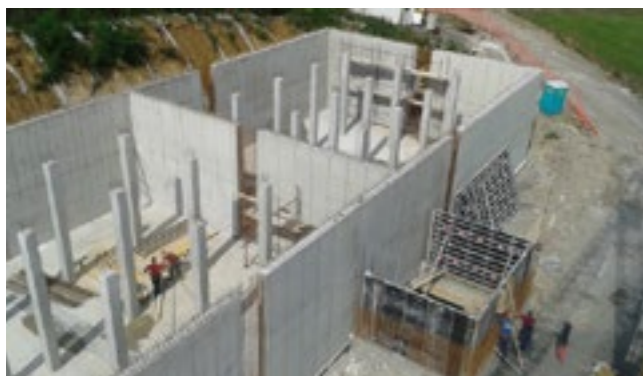
Auch mehrere Anlagen zur Versorgung mussten errichtet werden Several plants had to be installed for the water supply system
