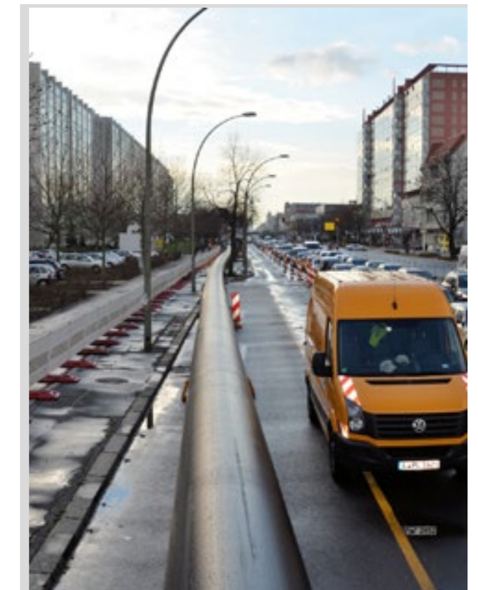
Der vorbereitete PE-Inliner wartet auf den Einzug The PE inliner is safely parked out of the way, ready to be inserted
