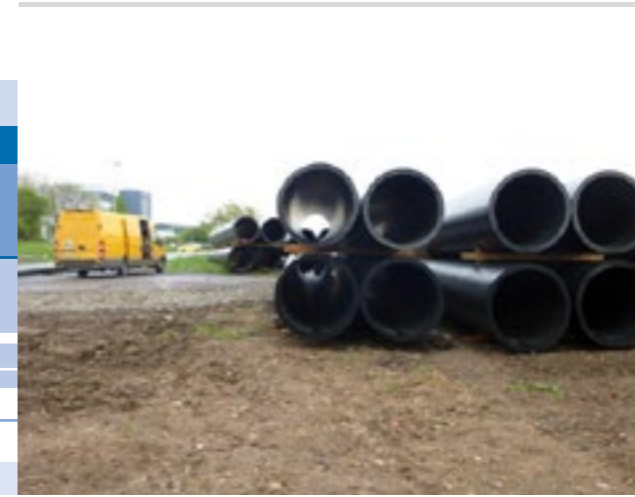
Die neuen PE-Rohre DN 1200 warten auf den Baustart The new PE pipes DN 1200 await the start of construction.
